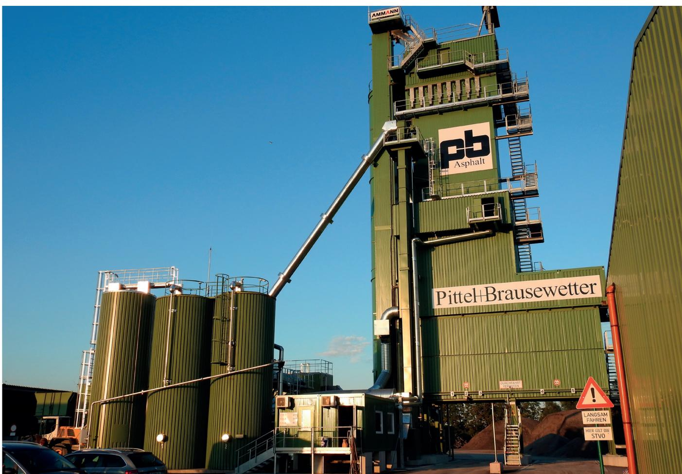
Der zur Filiale Tulln gehörige Bauhof in Nitzing verfügt über eine Asphaltmischanlage, eine Asphalt- und Betonrecyclinganlage und eine Werkstätte samt Ressourcen.
